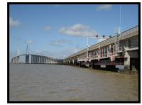
le renfort par précontrainte additionnelle et matériaux composites. Il est très spectaculaire, les travaux étant réalisés à partir de barges autonomes venant s'accrocher sur l'ouvrage avec l'appui des marées.
