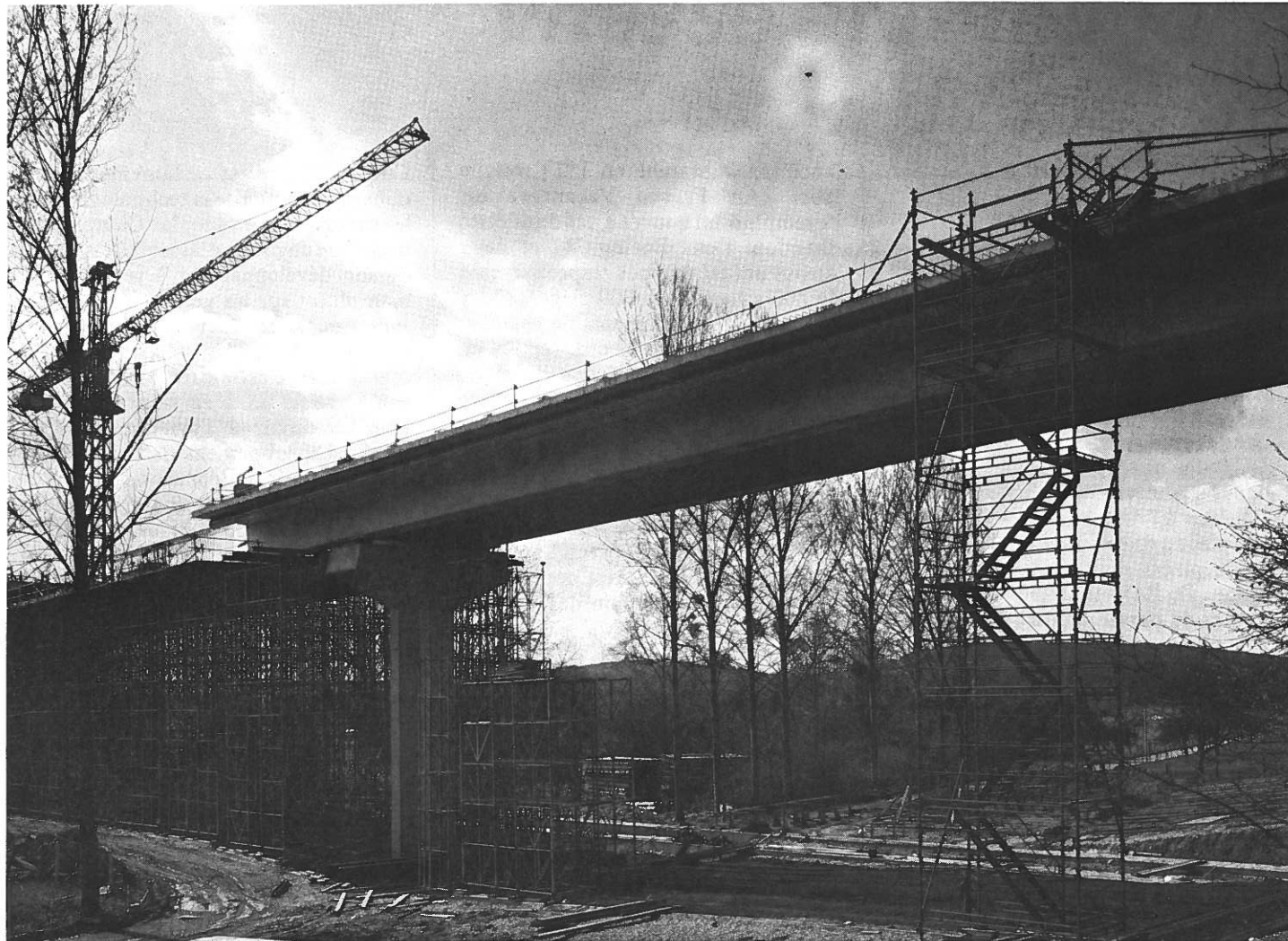
Le viaduc d'Acquigny
